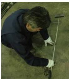
算出した必要寸法をマーキングしていきます。
